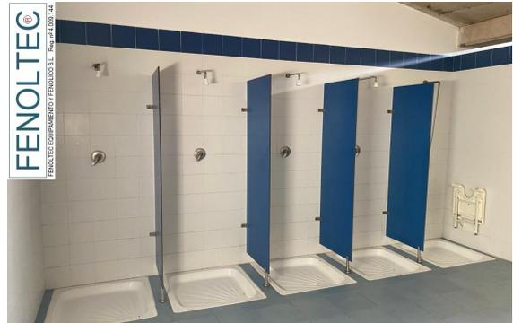
Los tableros de fenólico ofrecen muy alta resistencia al agua y a la humedad; así mismo son resistentes al uso continuado y son elementos versátiles. Es una solución para un cerramiento inalterable. Los tableros utilizados responden a la normativa de fabricación B-S1-d0 (Fuego - Humo - Gotas encendidas)
