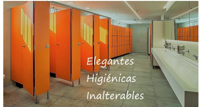
Los tableros de fenólico ofrecen muy alta resistencia al agua y a la humedad; así mismo son resistentes al uso continuado y son elementos versátiles. Es una solución para un cerramiento inalterable. Los tableros utilizados responden a la normativa de fabricación B-S1-d0 (Fuego - Humo - Gotas encendidas). Disponemos de todos los certificados relacionados.
