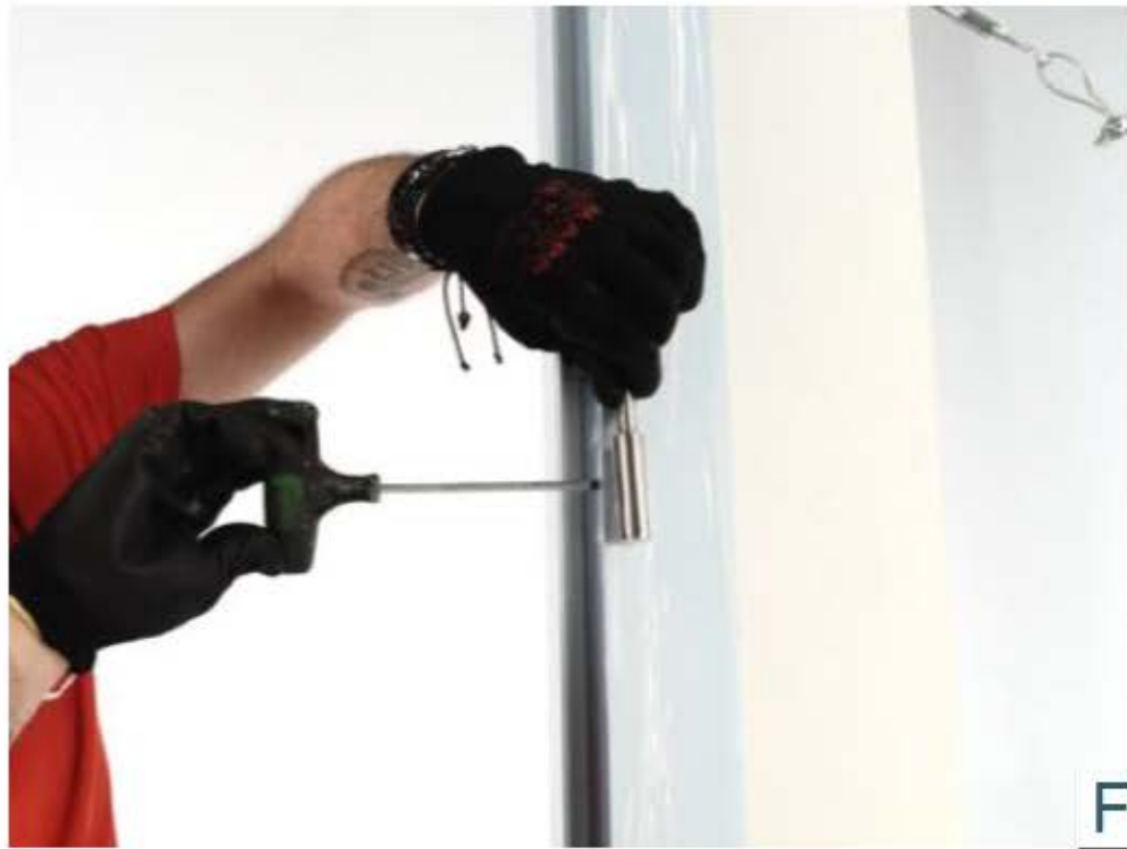
11-Colocar el pernio utilizando llave allen nº5
